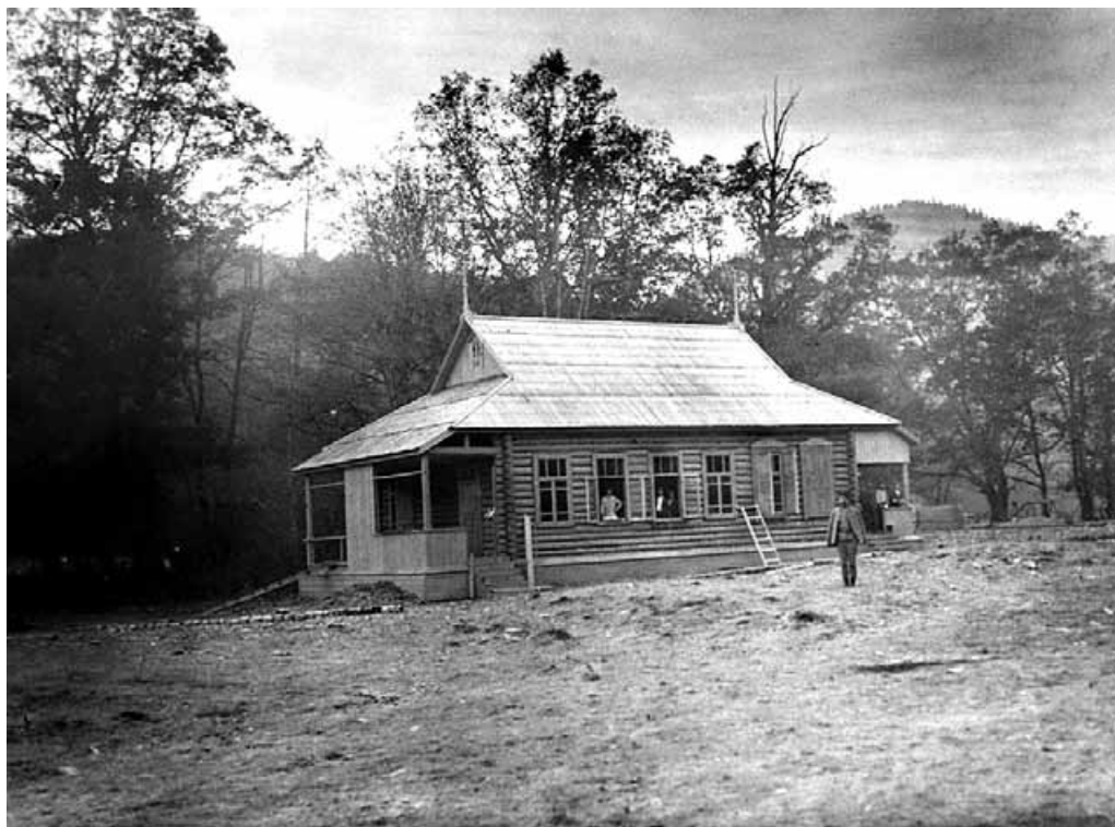
Строительство караулки в Гузерипле, 1926 г.
